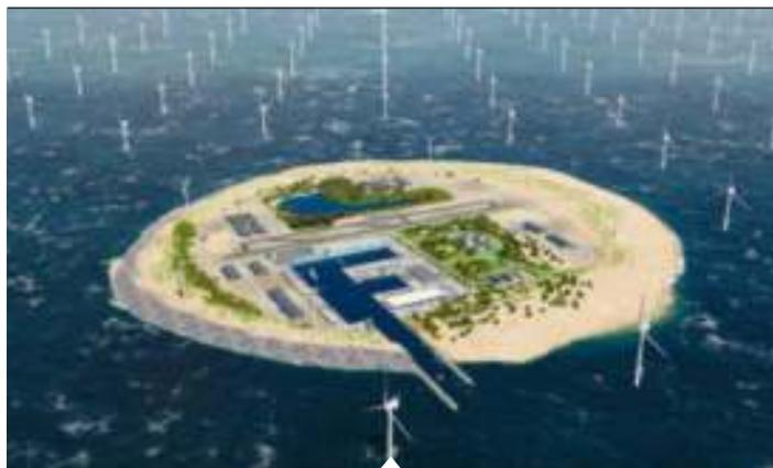
Le site sera couvert de panneaux solaires et environné de 7000 éoliennes ancrées dans des eaux peu profondes.
