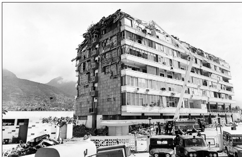
Fig. 24. La Mansión Charaima. Caraballeda 1967. La estructura fue inicialmente concebida para seis (6) pisos y le fueron construidos cuatro (4) más, los cuales se vinieron abajo a causa del terremoto.
